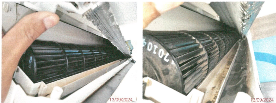
รูปภาพที่ 2.33 การล้างเครื่องปรับอากาศ
