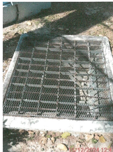
รูปภาพที่ 2.12 ตะแกรงดักขยะ และรางระบายน้ำ
