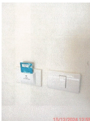
รูปภาพที่ 2.18 ระบบคีย์การ์ด ควบคุมการเปิด-ปิดไฟ ภายในห้องพัก
